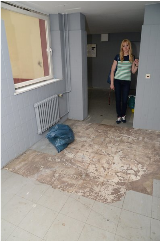
Isabelle Chatys (30) zeigt den sanierten Asbest-Boden. Foto: Thomas Lebie
